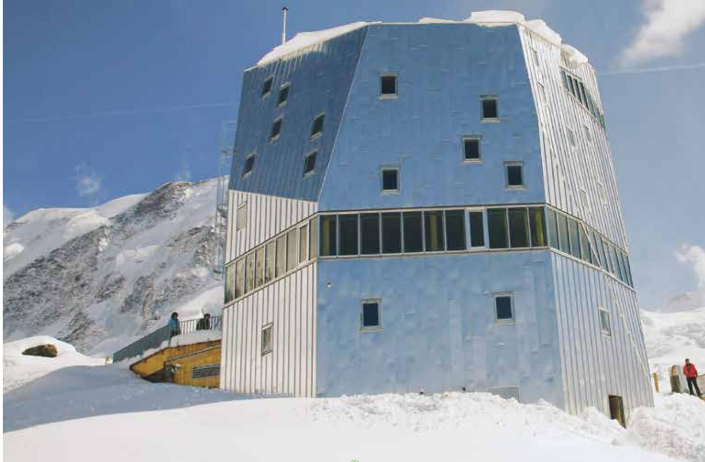
Dix ans après la mise en service de la nouvelle cabane Monte Rosa du Club alpin suisse (CAS), Siemens fait le point sur les aspects technologie et efficacité de ce bâtiment innovant, construit tout en bois habillé d'aluminium et prévu pour être autonome en énergie renouvelable à 90%.
